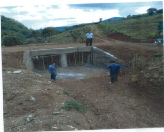
โครงการก่อสร้างท่อลอดเหลี่ยมเข้าสู่พื้นที่การเกษตร บ้านร่มฟ้าทอง หมู่ที่๑๘
