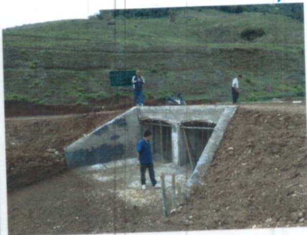
โครงการก่อสร้างท่อลอดเหลี่ยมเข้าสู่พื้นที่การเกษตร บ้านร่มฟ้าทอง หมู่ที่๑๘
