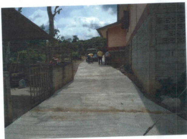
โครงการก่อสร้างรางระบายน้ำพร้อมฝापิด บ้านดอน หมู่ที่๓
